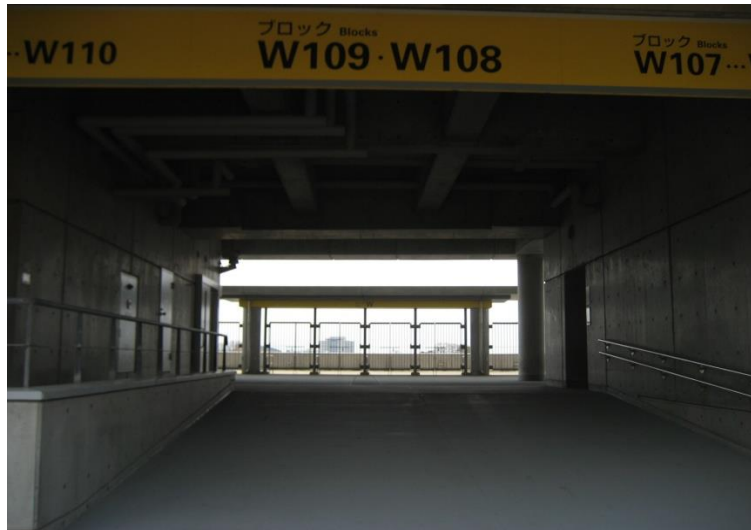
スタンド出入口通路
